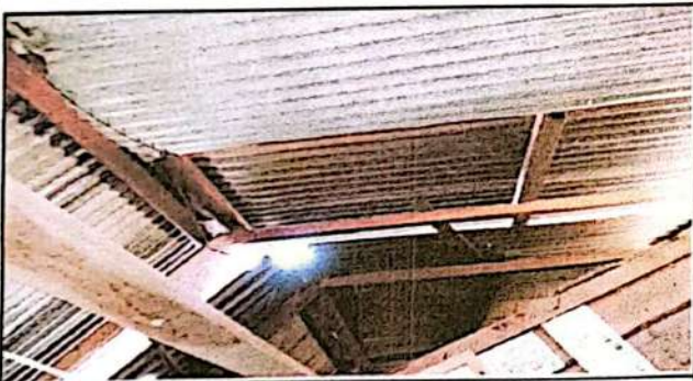
Foto 3: SUSTITUCION DE LAMINAS.
